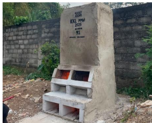
Gambar 6. Rocket Stove Setelah Selesai Dibangun
